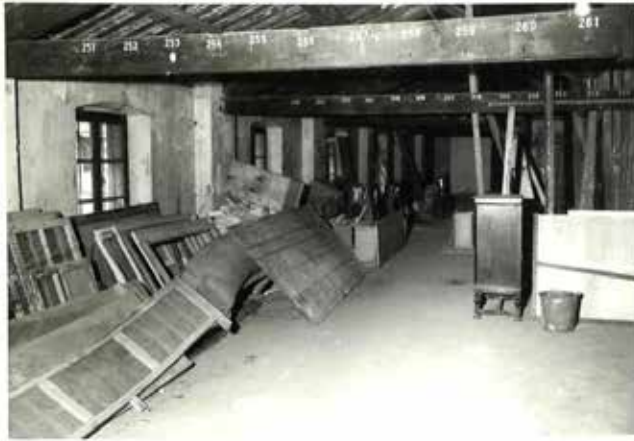
SOLAI DI LEVANTE DURANTE I LAVORI
