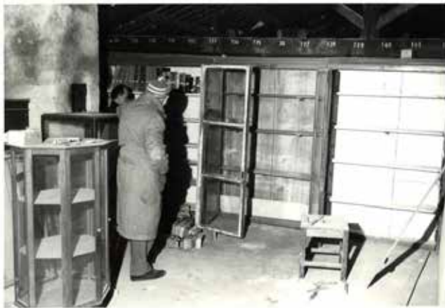
SOLAI DI LEVANTE DURANTE I LAVORI
